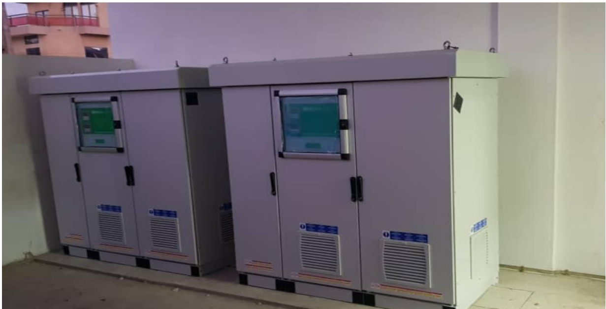
Figure 16 : Stabilisateur de tensi
