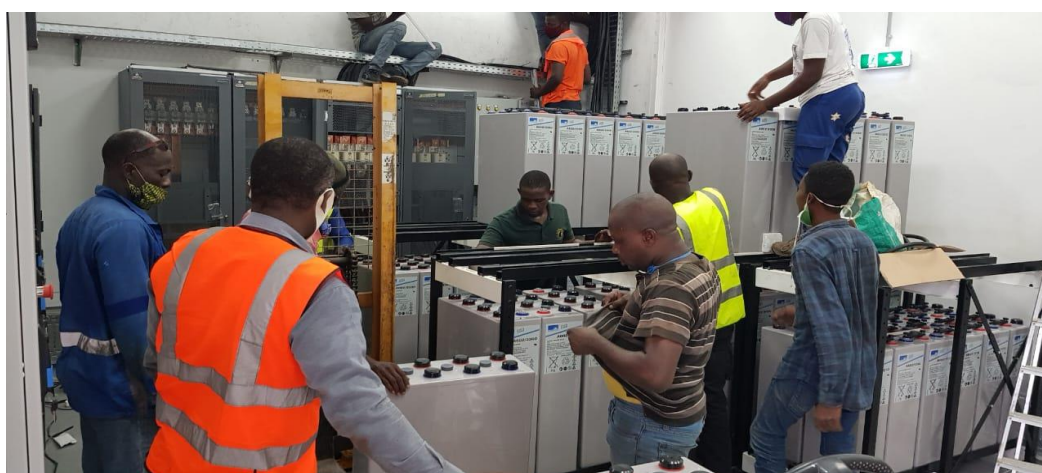
Figure 2: Entretien des batteries
