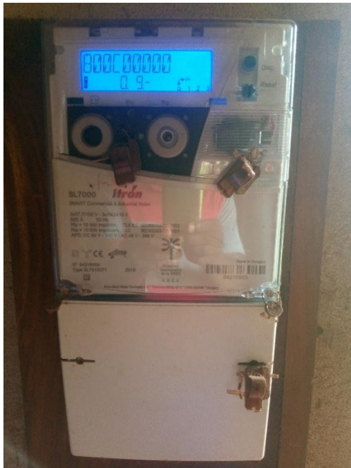
Fig1 : Compteur électronique SL 7000
