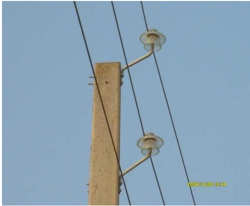
Figure 5 : Isolateur VHT 22T sur le réseau HTA de Pobè
