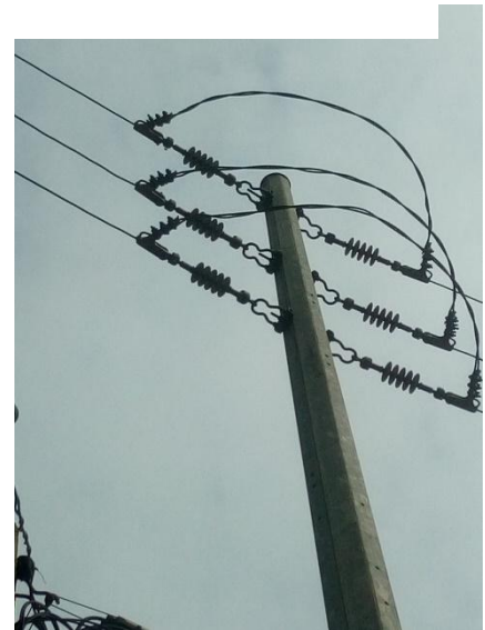
Figure 4 : Chaîne d'isolateur servant d'ancrage sur le réseau HTA
