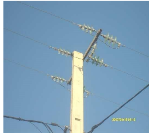
Figure 4 : Chaîne d'isolateur servant d'ancrage sur le réseau HTA
