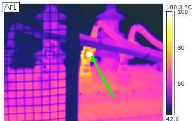
Fig. 22 :Borne BT en défaut vue par caméra infrarouge
