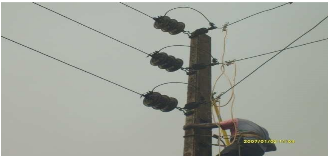
Agent plaçant un dispositif de mise à la terre et en court- circuit sur un poteau HTA
