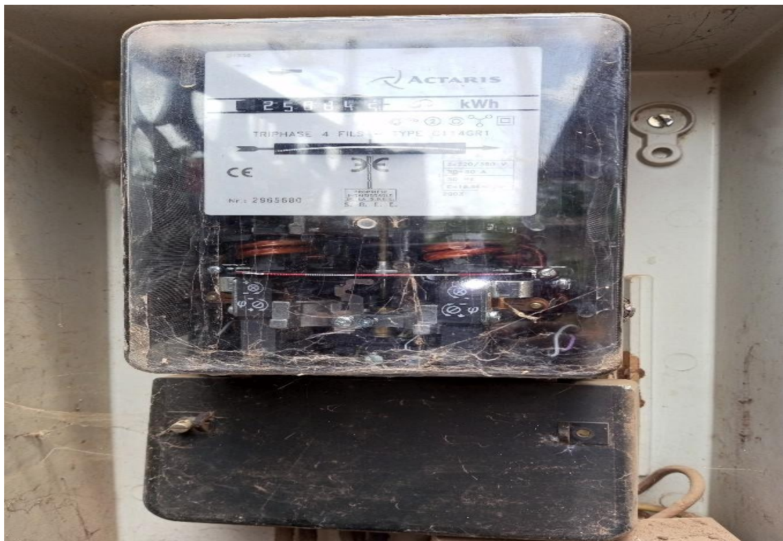
Fig3 : Compteur post payé ou conventionnel
