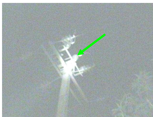
Fig. 27 : Borne HTA de l'IACM en défaut vue par caméra infra Rouge
