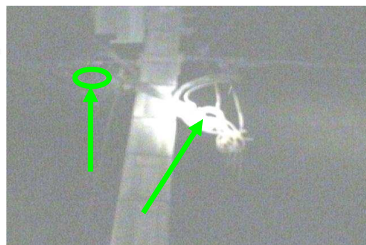
Fig. 26 : Câble BT en défaut vue par caméra infrarouge
