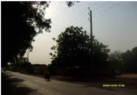
Fig18 : Feuillage d'arbre dans le réseau HTA
