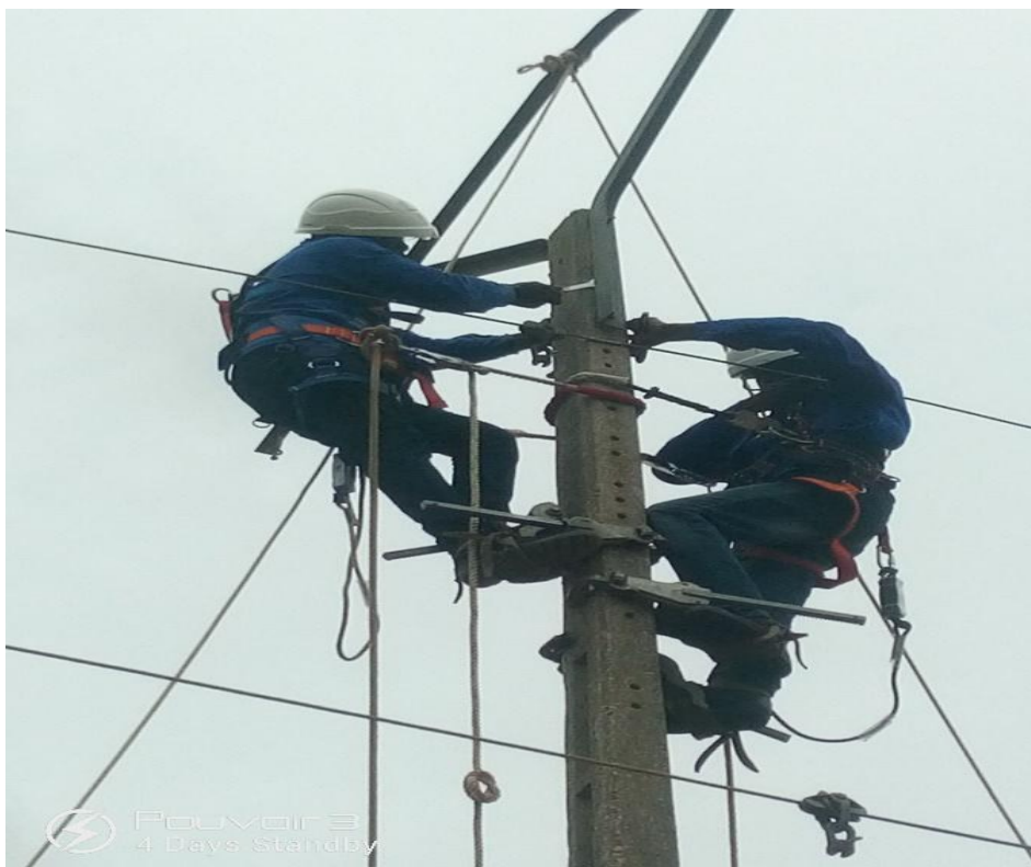
Fig1 : Remplacement de nappe-voute troussé
