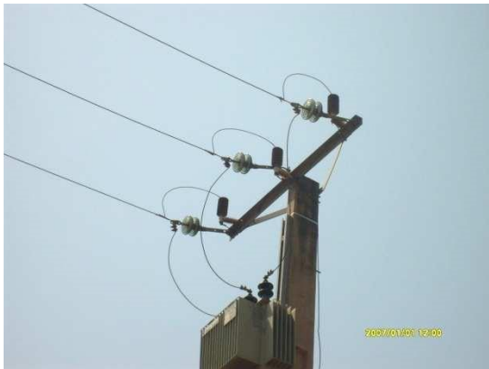
Fig1: Parafoudre HTA protégeant un Transformateur
