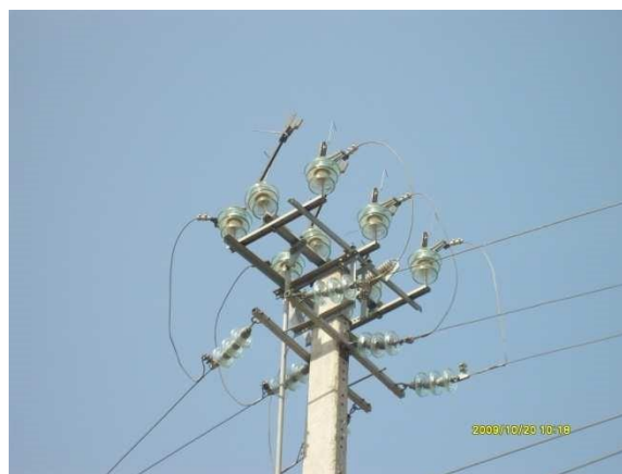
Fig1 : IACM de 50A alimentant le Lycée Technique de Pobè
