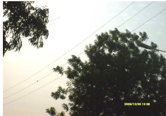
Fig19: Feuillage d'arbre dans le réseau HTA
