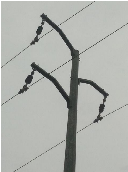
Figure 5 : Isolateur VHT 22T sur le réseau HTA de Pobè
