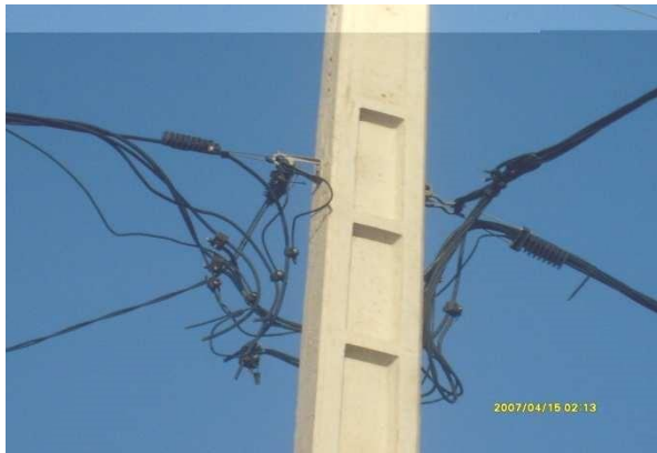
Figure 2 : Réseau BT en autoporté
