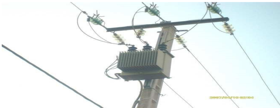
Fig1 : Transformateur 100KV/20KV sur Poteau
