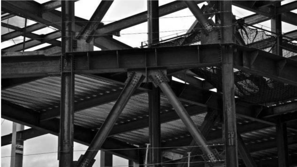
Figure 1-3 : Vue inférieure d'une dalle mixte coulée sur une tôle nervurée. Photo de Orest Ukrainsky
