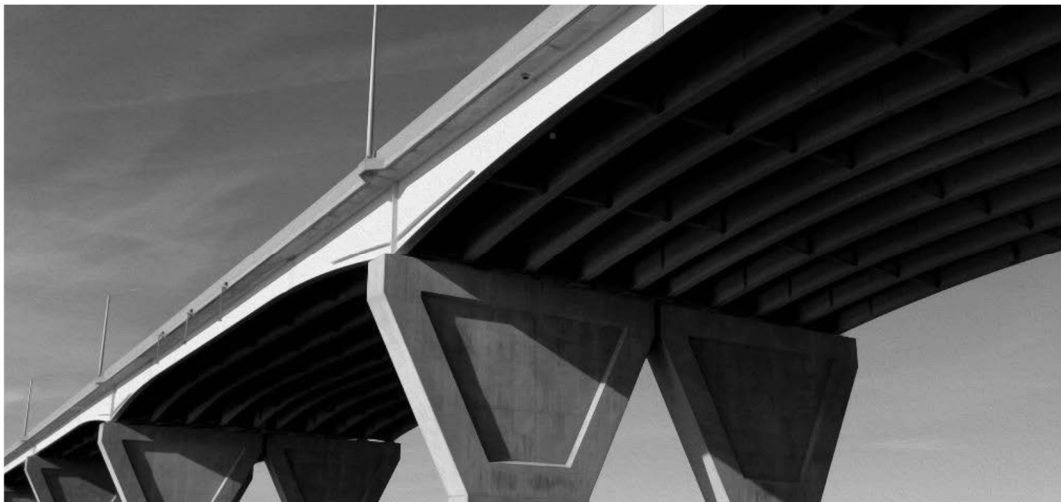
Figure 1-2 : Ouvrage mixte pour lequel un grand nombre de poutres de faibles dimensions ont été mises en place, photo de Christophers Sessums
